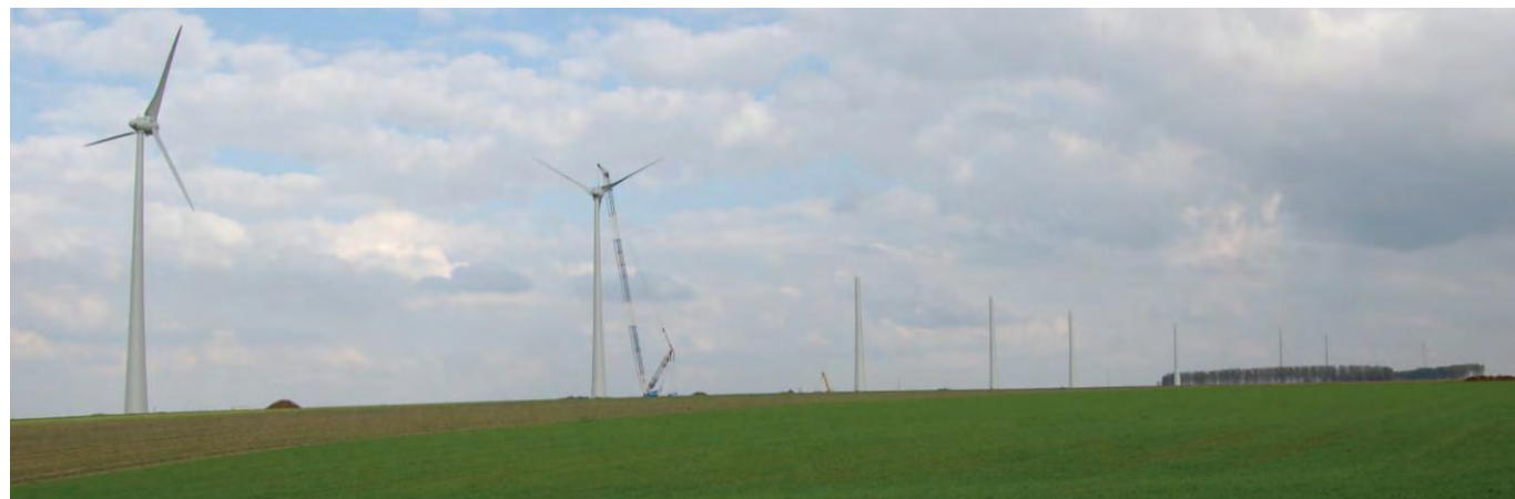
Figure 4 : Travaux du projet « Le Nouvion », parc de 24 éoliennes (Source : Intervent)
