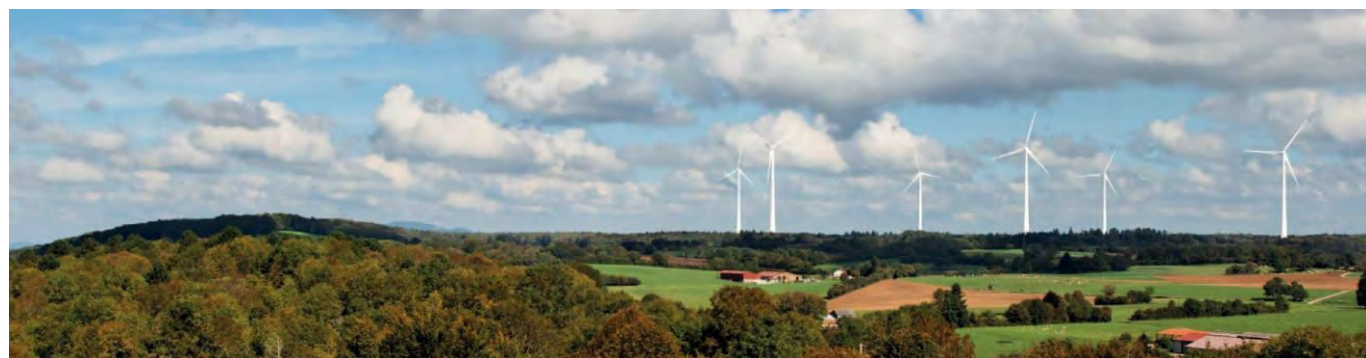
Figure 3 : Parc éolien de Chamole (18MW) construit en 2017 (Source : Intervent)
