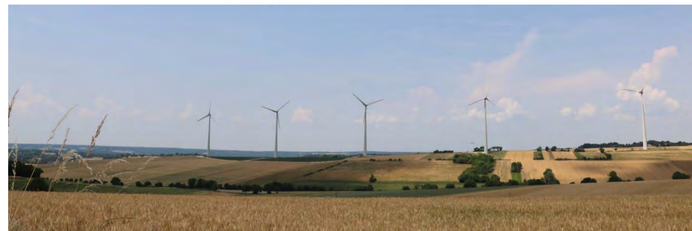
Figure 2 : Parc éolien de Bouhy (11,5MW) construit en 2017 (Source : Intervent)
