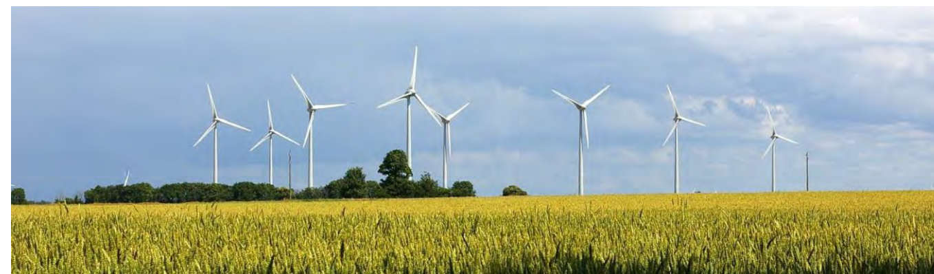
Figure 1 : Parc éolien de Garcelles-Sequeville (16MW) construit en 2008 (Source : Intervent)
